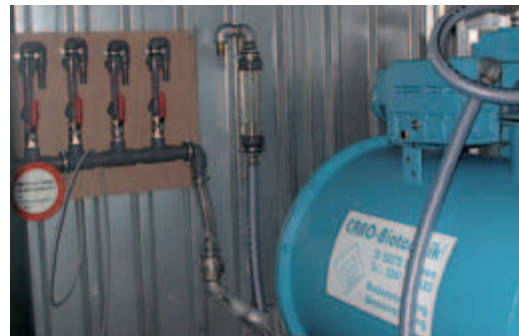
VAK 100 für 4 Vakuumbrunnen in Montage
